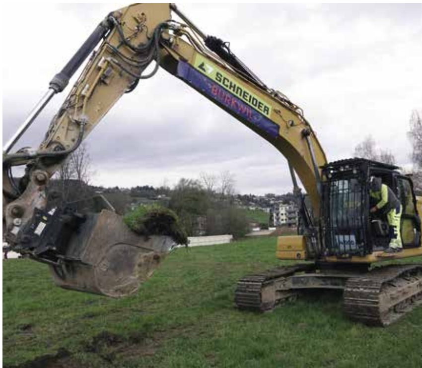
Der Spatenstich für die Mehrgenerationensiedlung der Stiftung Burkwil erfolgte nicht wie üblich mit der Schaufel, sondern mit dem Bagger. Fotos: MAZ
